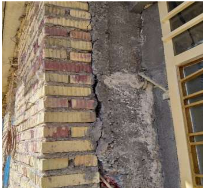
اجرای دیوار خارج از کلاف
